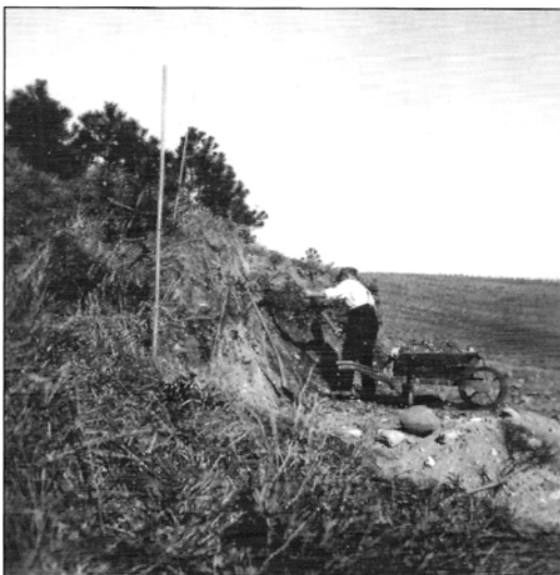
Grunden udgraves til sommerhuset Bjerget 14.
